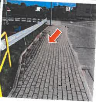
most ul. Sikorskiego / 8-go maja, deformacja chodnika, osiadanie skarpy między jezdnią a rzeką Okalicą
