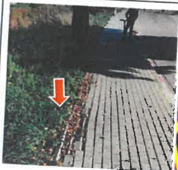
most ul. Sikorskiego / 8-go maja, deformacja chodnika, osiadanie skarpy między jezdnią a rzeką Okalicą
