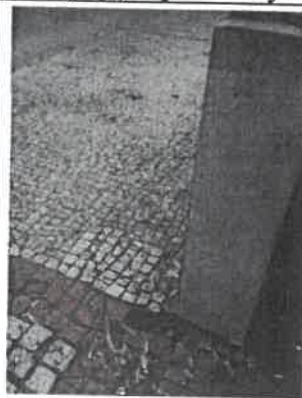
most Armii Krajowej, zapadanie zabruku, wypłukiwanie gruntu spod chodnika, postępująca deformacja umocnienia skarpy przyczółku
