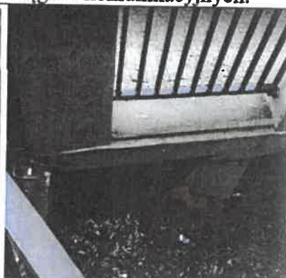
most Armii Krajowej, zapadanie zabruku, wypłukiwanie gruntu spod chodnika, postępująca deformacja umocnienia skarpy przyczółku
