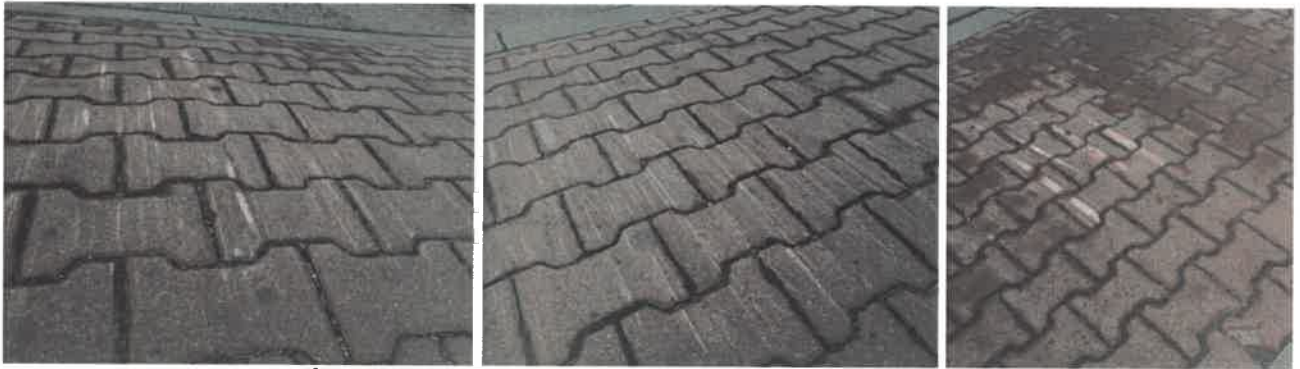
Ślady uderzeń podwozia na przedmiotowych progach.
