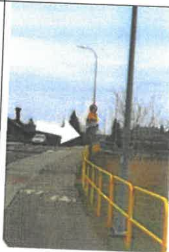
ul. Lotników, obrócona tarcza znaku B-33 ( Ponownie ) (dobrym rozwiązaniem wydaje się przenieść na odpowiednią wysokość znaki ze słupka na słup latarni ulicznej widocznej na pierwszym planie)
