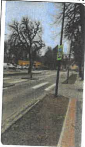
Al. Wolności przy Orliku, obrócona tarcza znaku D6 (podobna sytuacja na tej samej ulicy na przejściu przy SP nr 3)
